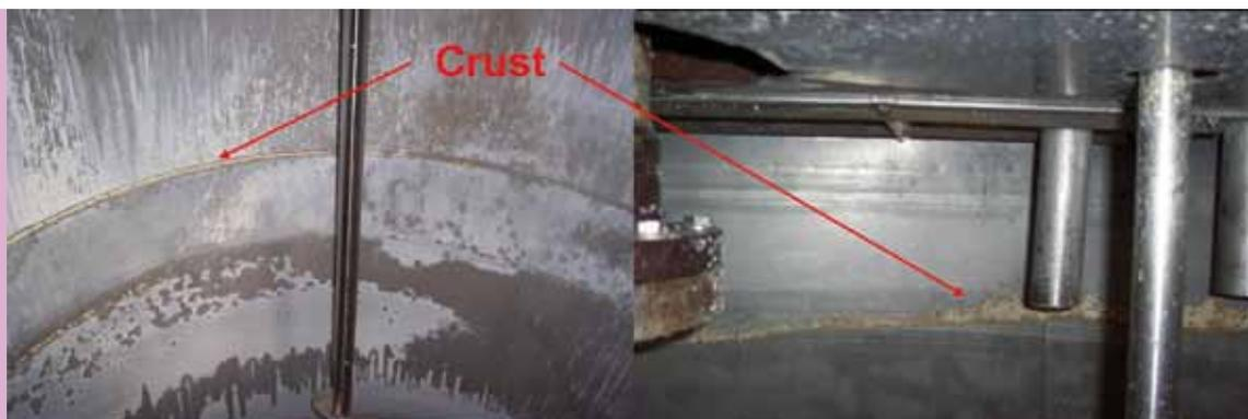
图4视觉检查反应器内壁，发现一些不希望的原料仍然存在，因此需要进一步清理
